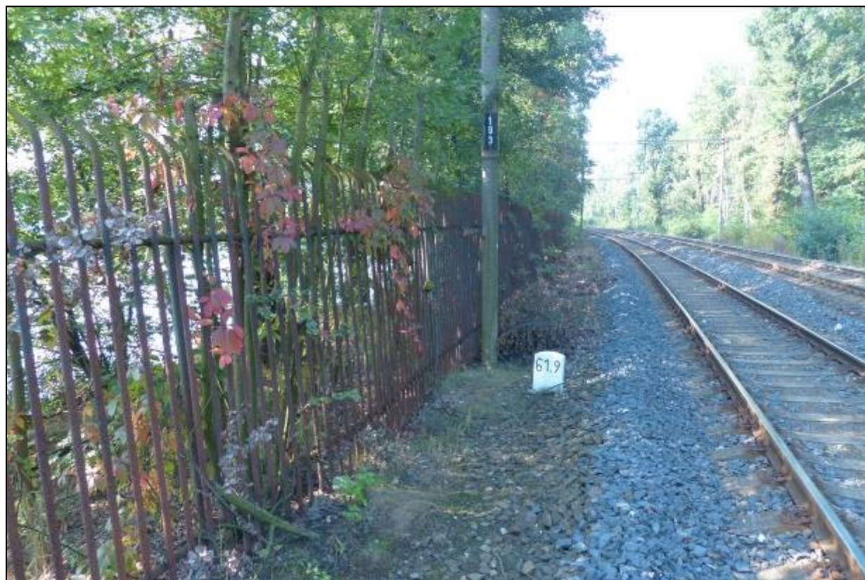
Foto 5. V úseku vedoucím okolím Kamencového jezera (km 61,9) na železniční těleso přesahují dřeviny a liány z okolních pozemků (loubinec popínavý).
